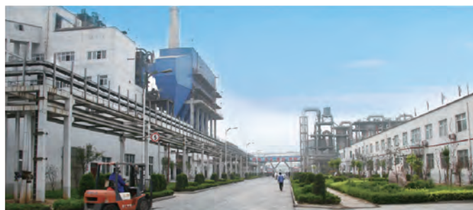
最大氧气底吹铅熔炼炉 河南济源金利铅冶炼厂
