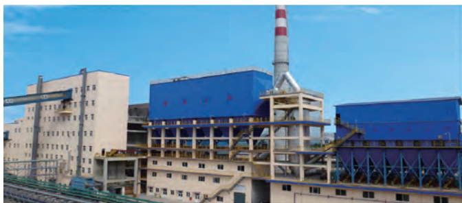
铅精矿搭配处理金精矿 山东恒邦铅冶炼厂
