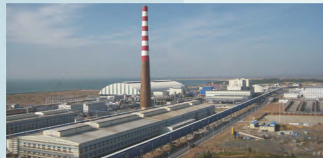
广西金川防城港项目 Project in Fangchenggang City for Guangxi Jinchuan Nonferrous Metals Co., Ltd.
