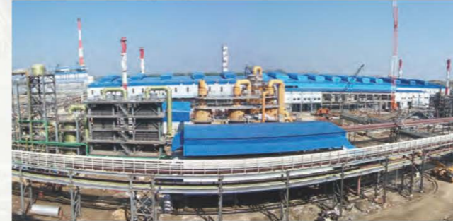
印度德里巴底吹炼铅项目 Dariba SKS Technology Lead Smelting Project, India
