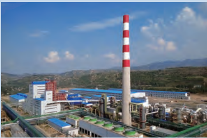
中原冶炼厂氧气底吹造钼捕金项目 规模：1,500kt/a 精矿
