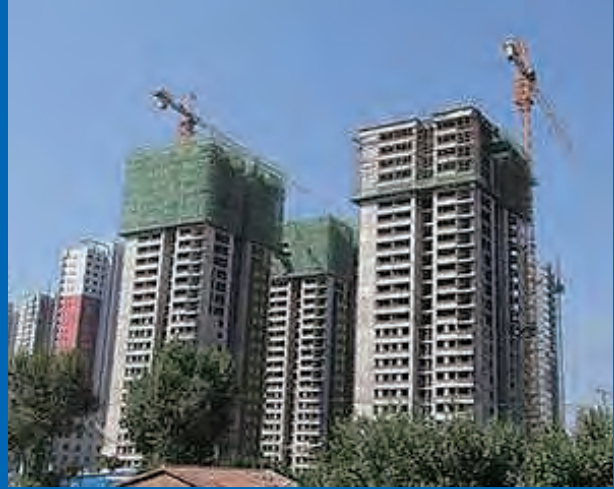
▲ 北京丽泽金融商务区A02定向安置房项目
