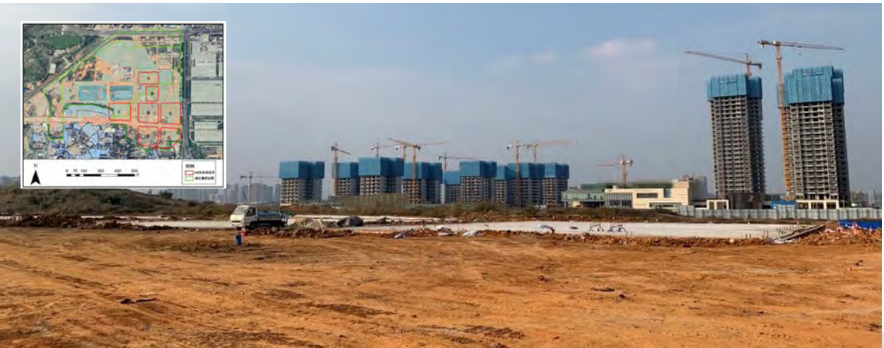
▲ 南宁江南中心项目土壤污染治理设计及施工工程
