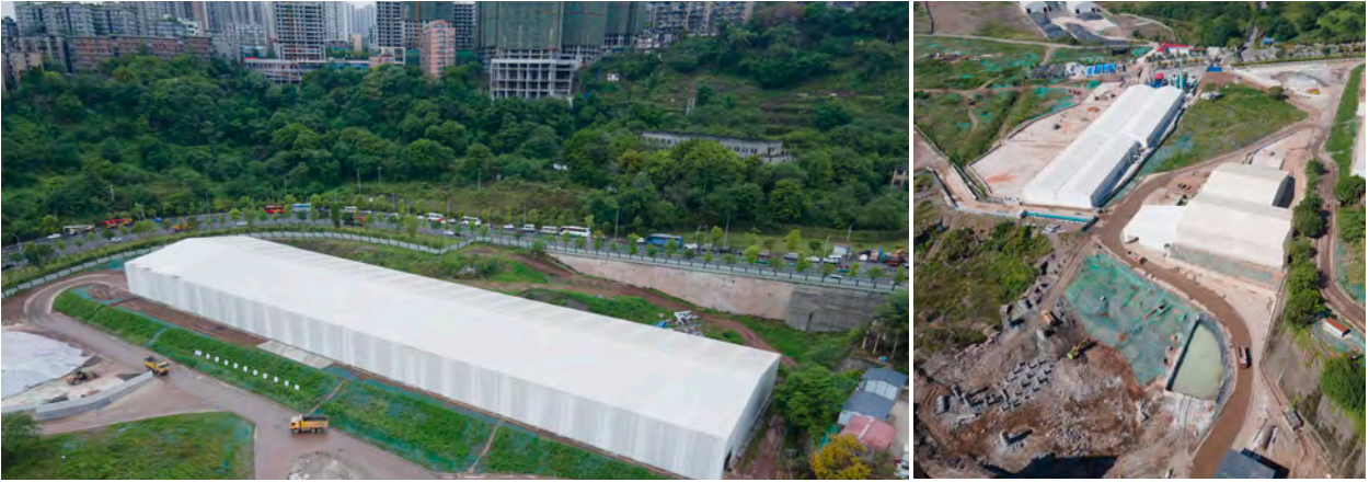
▲ 重钢炼铁厂原址场地污染土壤治理修复项目设计及施工
