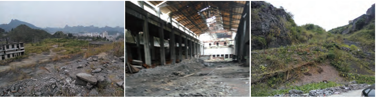
▲ 南丹县龙泉矿冶总厂铅锑冶炼厂、锡冶炼厂旧址场地治理修复项目
