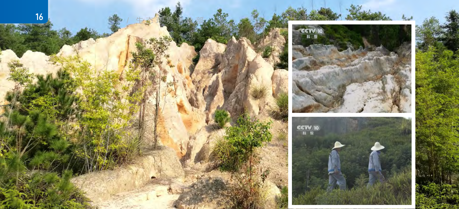
▲ 赣县区大田乡废弃稀土矿区重金属综合治理工程EPC总承包项目
