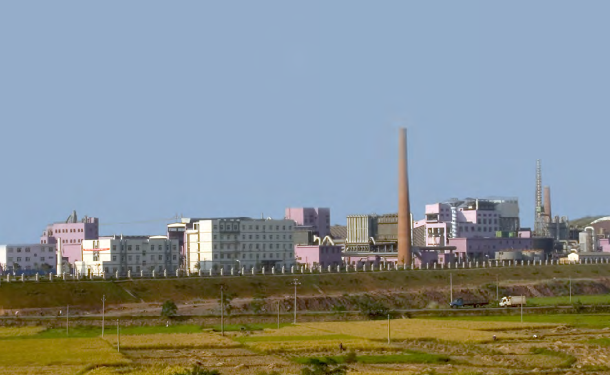
▲ 北方铜业股份有限公司垣曲冶炼厂处理50万t/a多金属矿综合捕集回收技改项目
