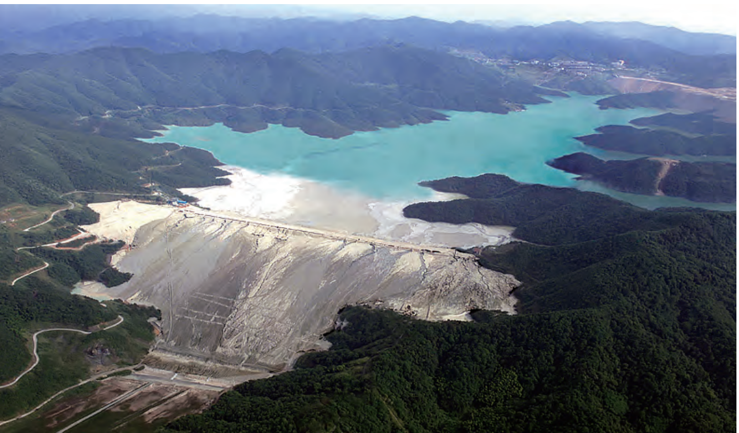
▲ 江西铜业股份有限公司德兴铜矿五号尾矿库项目
